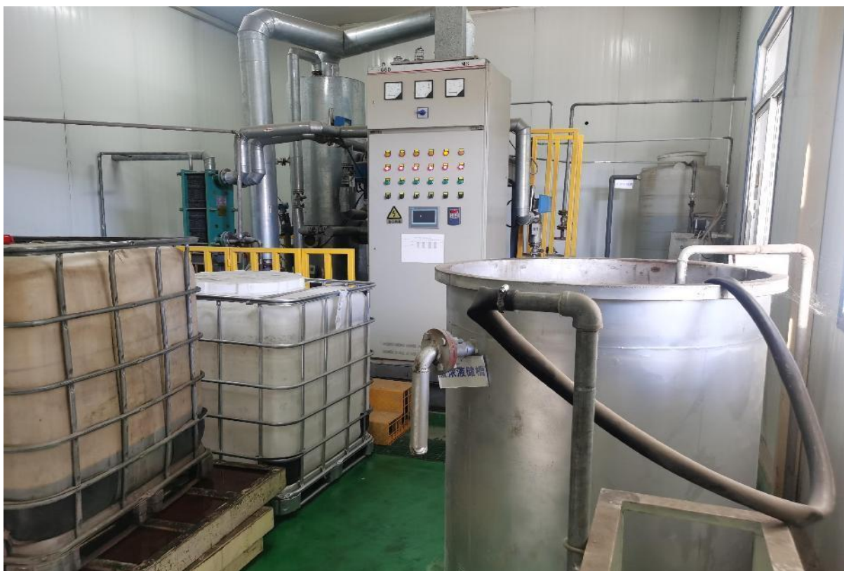
MVR 废液处理间油水分离装置拆除前
