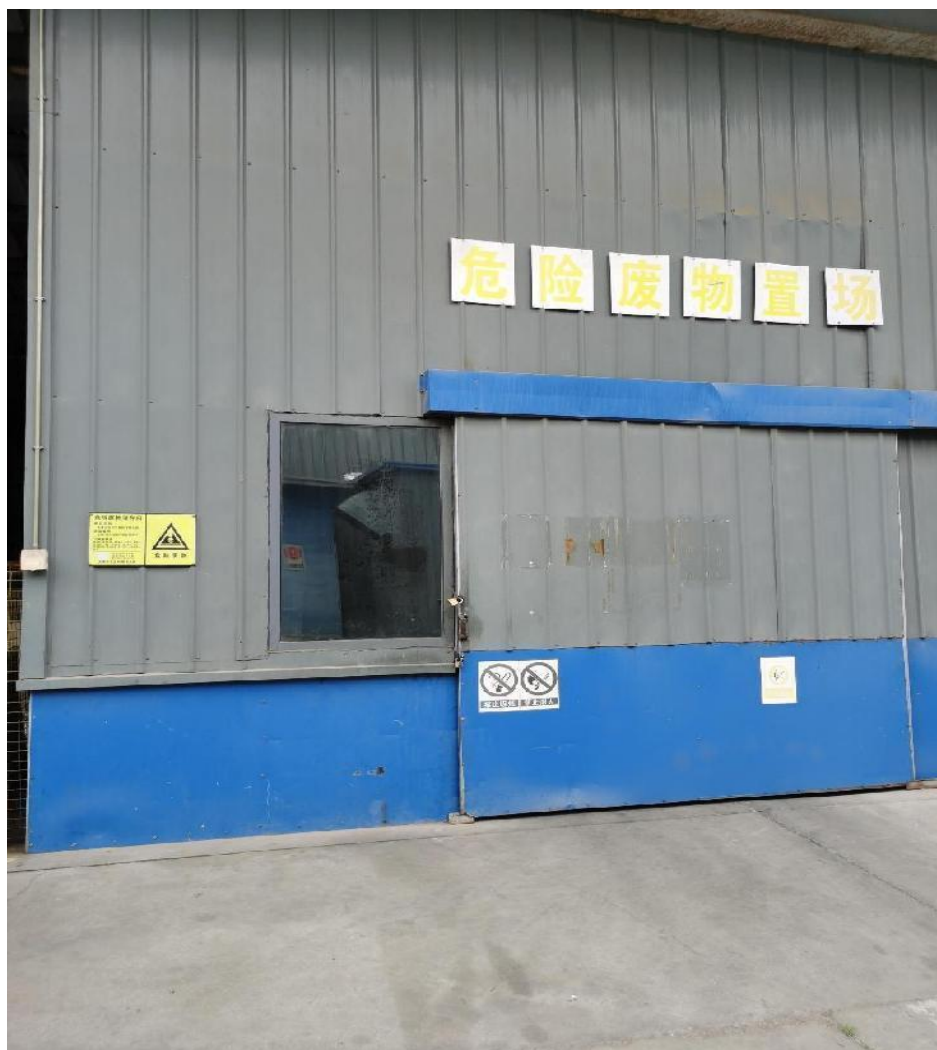
危废间外部照片
