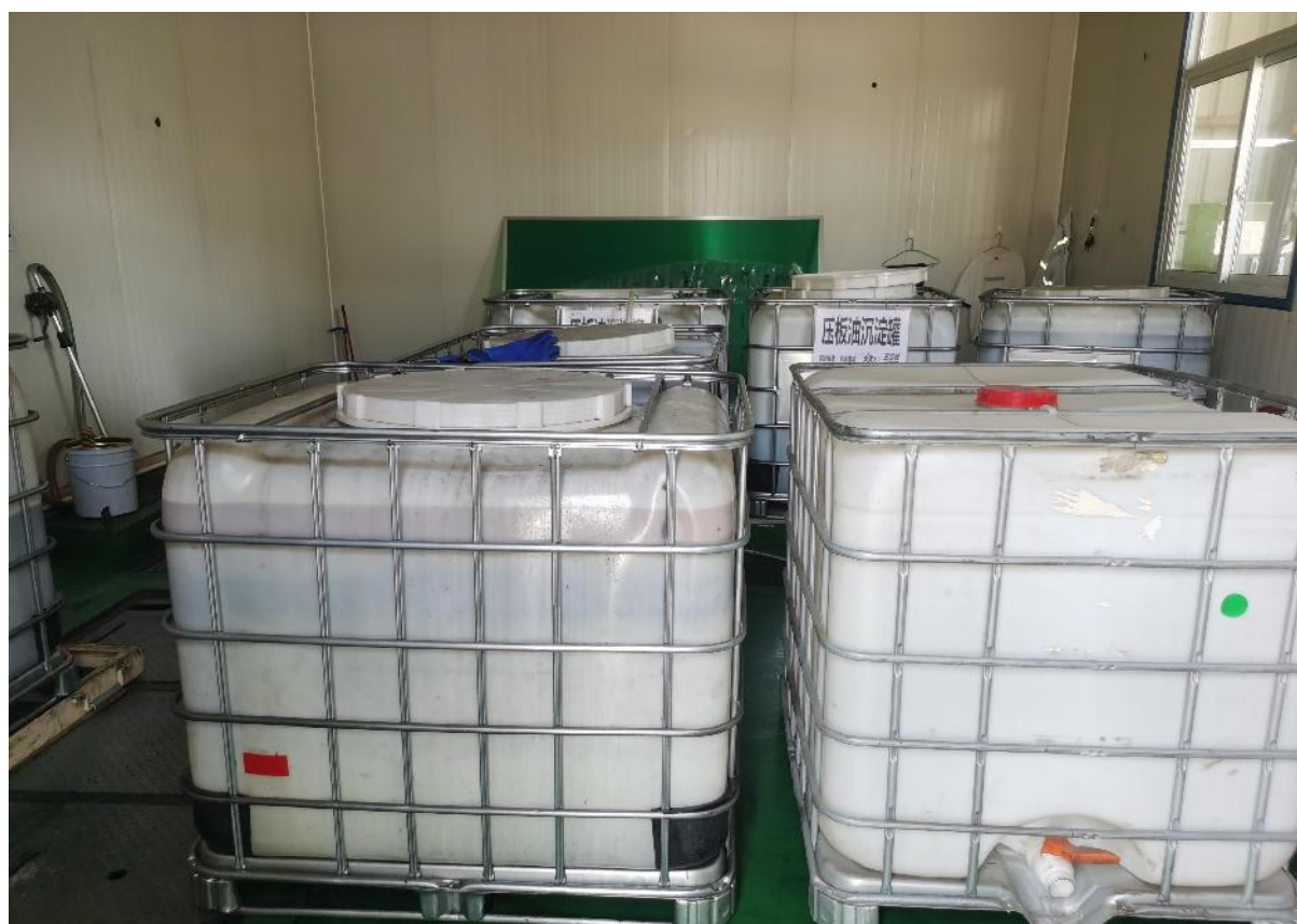
MVR 废液处理间油水分离装置拆除后
