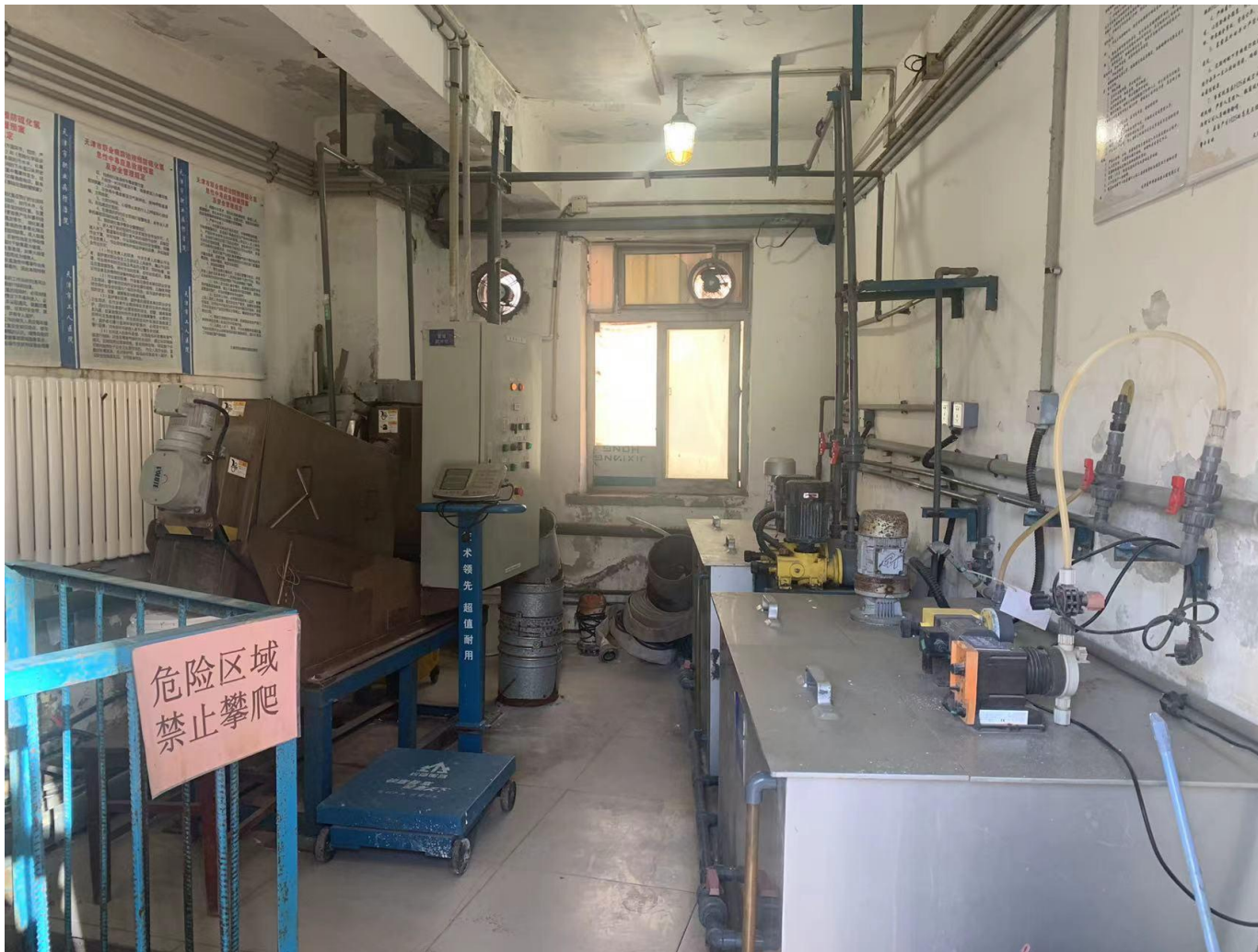
附图 6.2.2 污水站操作间
