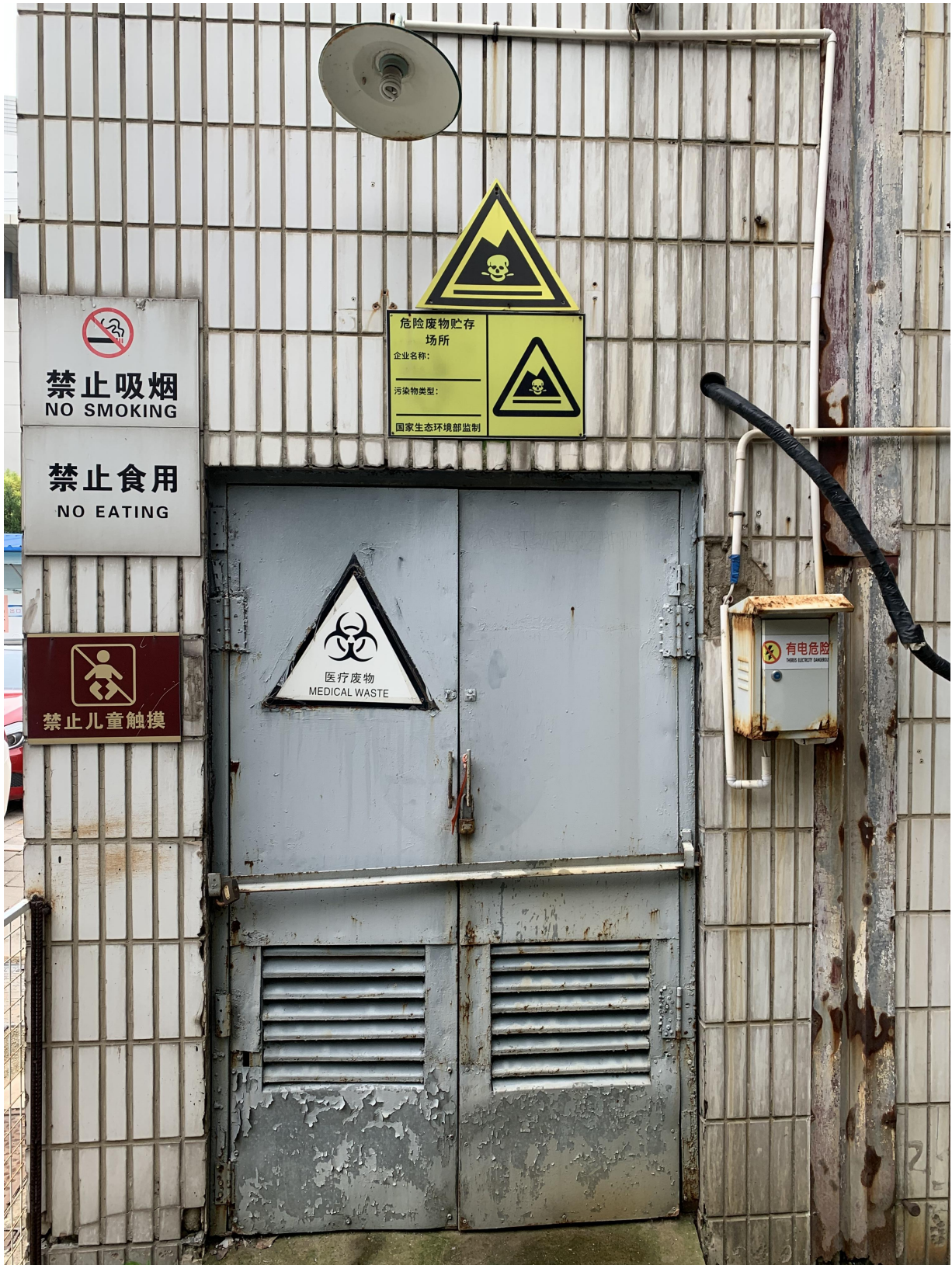
附图 5.4.1 危险废物暂存间规范化
