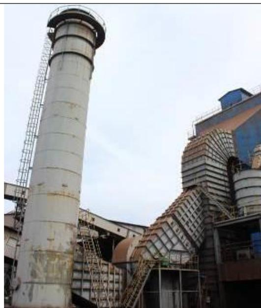
烧结机尾除尘系统排气筒
