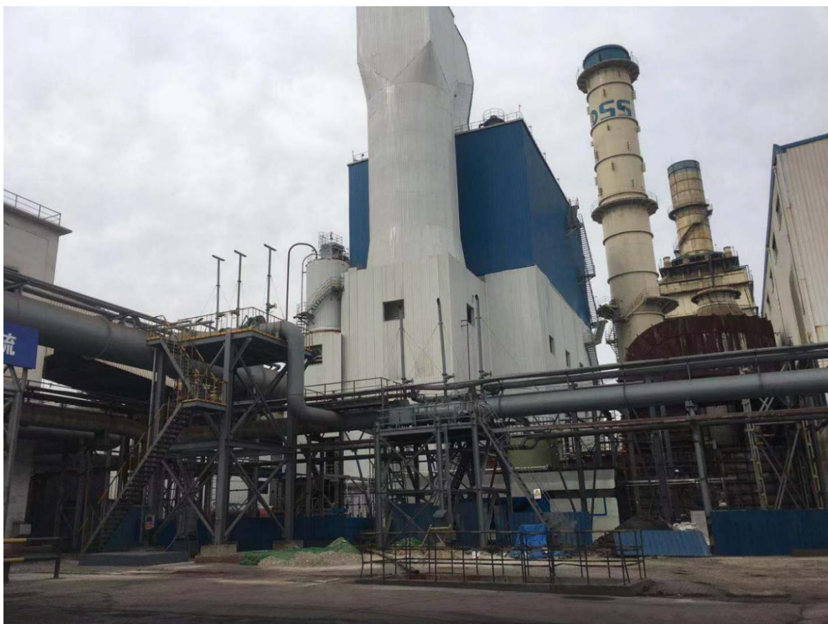
230m 2 烧结机脱硫脱硝设备
