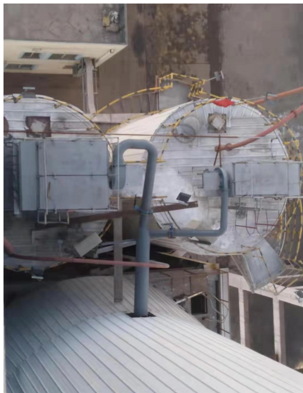
球团回转窑脱硫原料仓回流装置
