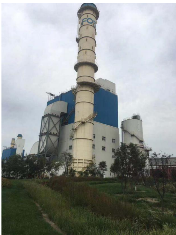
265m 2 烧结机脱硫脱硝排放筒
