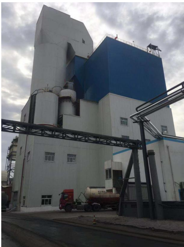
265m 2 烧结机脱硫脱硝
