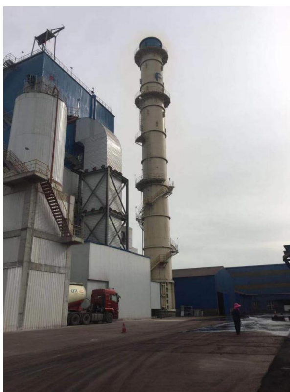
230m 2 烧结机脱硫脱硝排放筒
